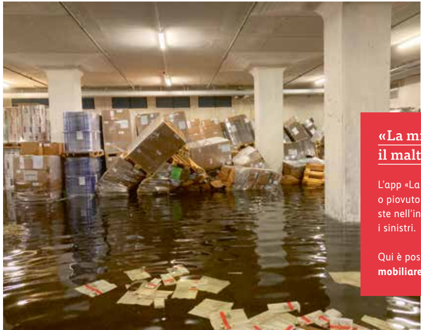
Il piano sotterraneo della fabbrica di zucchero è stato inondato da quasi un metro d'acqua.
